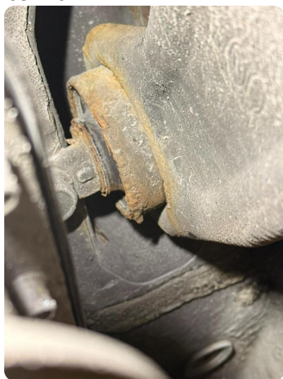
3.1 Slitt bærefuoring Fremre bærefuoring h.s.b har begynt å slippe, i grenseland til pkk
